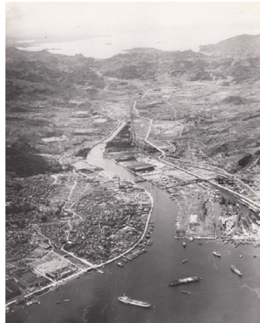
原爆投下から1年後の長崎港 上空から見た浦上方面。1946 (昭和21)年(長崎原爆資料 館蔵)
