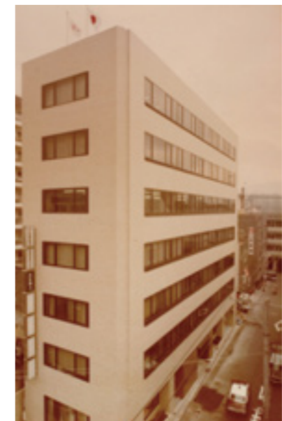
長崎市五島町に松藤グループ新本社ビル完成(1977年)
