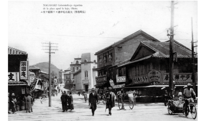
大波止電車通りより県庁を望む (昭和初期) 写真提供:アソシエ地図の資料館
